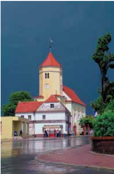
Centrum Przemkowa. Kościół Wniebowzięcia NMP
