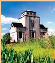
Przepompownia w Leszkowicach
