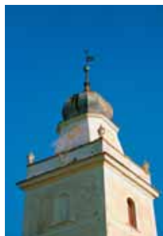
Wieża kościoła w Sobinie
