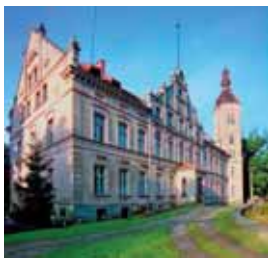
Pałac w Nowym Dworze
